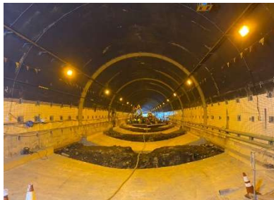
インバート設置工事の様子
