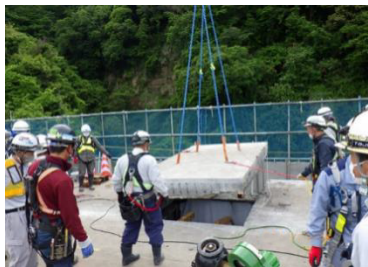
既設コンクリート床版の撤去
