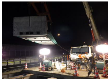
新設コンクリート床版の設置
