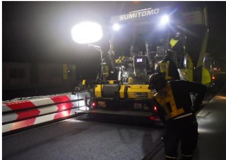
舗装の補修状況
