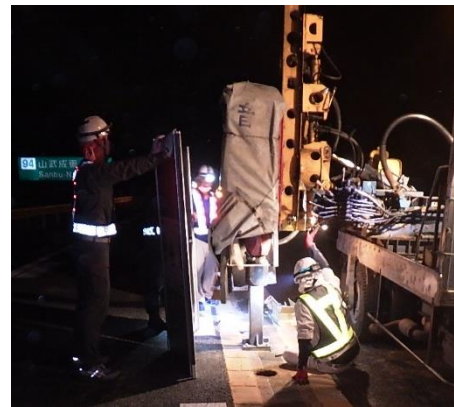
ワイヤーロープ新設工事
