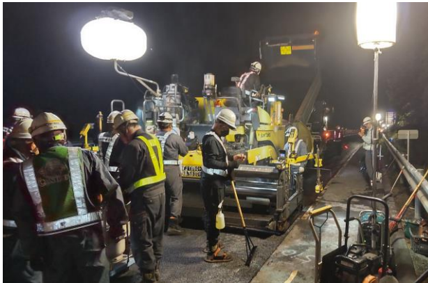
舗装補修工事
