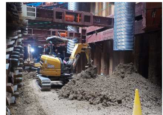
④開削範囲の埋め戻し
