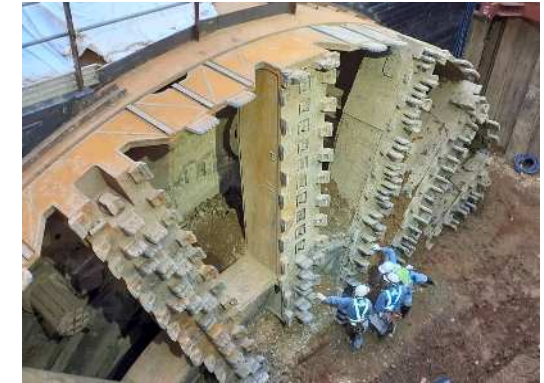
②損傷した部材等の確認
