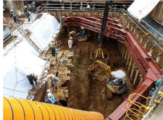
①地上からの開削作業
