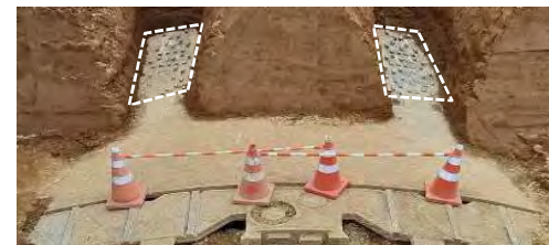
裏込め注入管保護ビット 【裏込め注入材を注入するための管を保護する部材】
