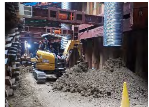
④開削範囲の埋め戻し
