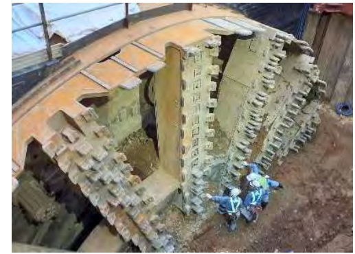
②損傷した部材等の確認
