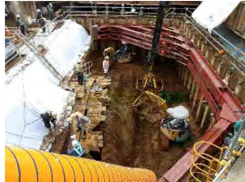
①地上からの開削作業
