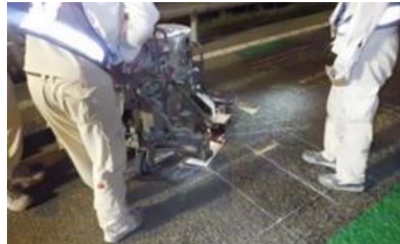
逆走対策工事 作業状況
