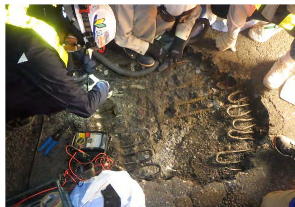
ロードヒーティング補修工事例
