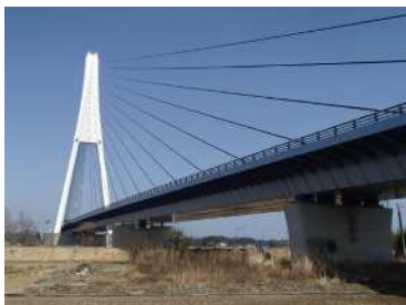
新那珂川大橋
