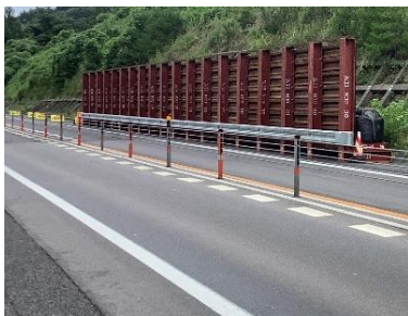
仮設落石防護柵設置状況
