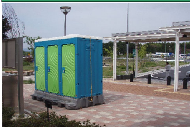
臨時トイレの設置
