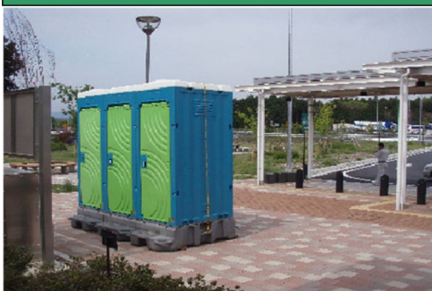
臨時トイレの設置
