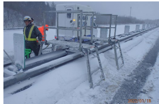
トイレカーと中央分離帯乗り越え梯子の設置 (事例:R4.1.18磐越道交通事故による滞留発生時)
