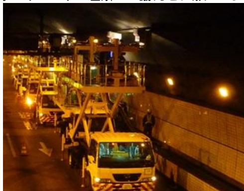
構造物点検状況
