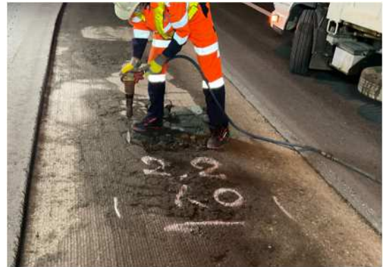
床版補修工事 作業状況
