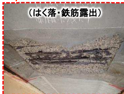
床版下面の損傷状況①
