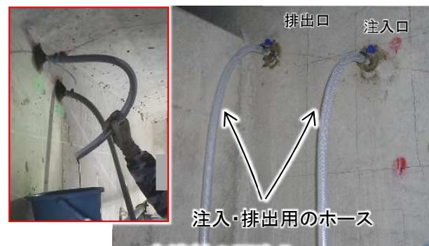
注入・排出用のホース 充填材の再注入
