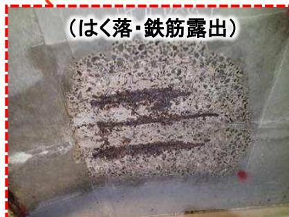
床版下面の損傷状況②
