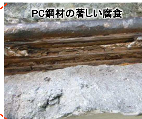
PC鋼材の変状状況
