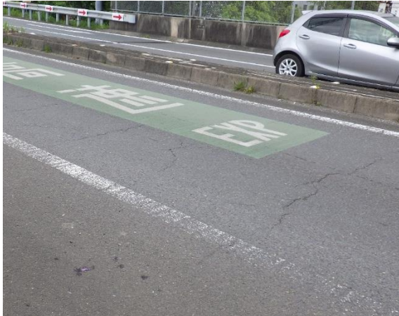
舗装損傷状況
