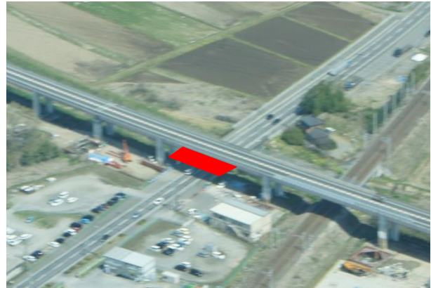
【相吊り一括架設部(赤色部)】
