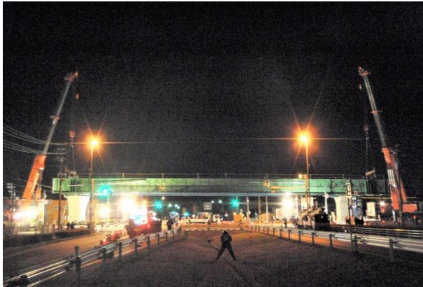
【相吊り一括架設工事の様子(参考)】
