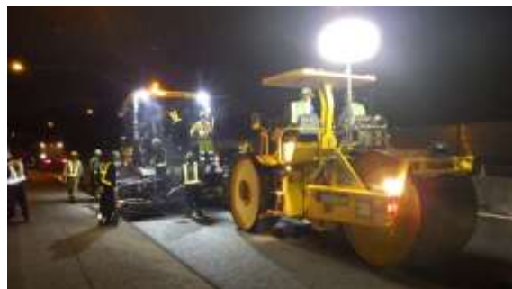
舗装補修工事 作業状況
