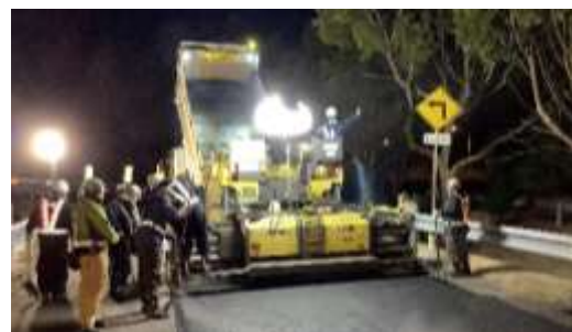
舗装補修工事 作業状況
