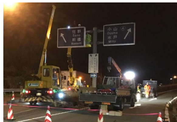
標識取替工事 作業イメージ
