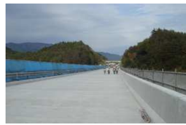
新設コンクリート床版施工完了※
