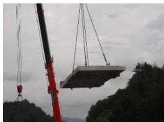
既設コンクリート床版の撤去※
