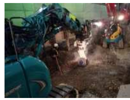
インバート掘削状況
