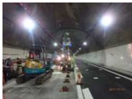
土留杭打設状況
