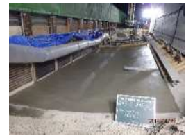
コンクリート打設完了
