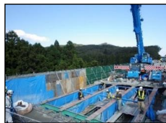
【古い床版撤去状況】
