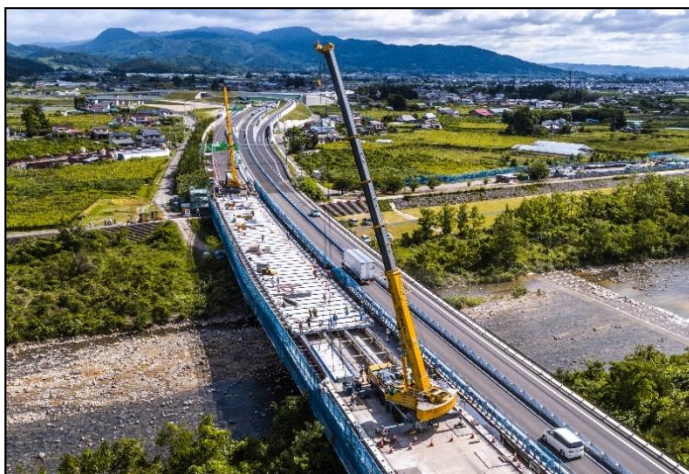
【対面通行規制状況】
