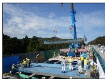
【新しい床版設置状況】
