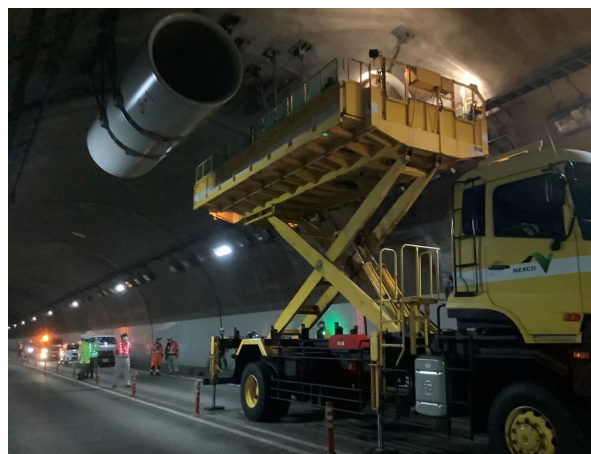
トンネル点検
