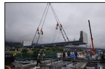
【新しい床版設置状況】
