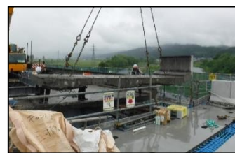
【古い床版撤去状況】
