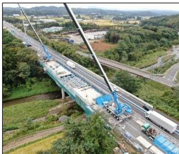
【対面通行規制状況】
