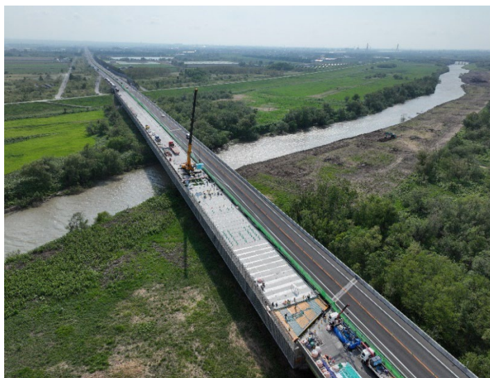
【対面通行規制状況】
