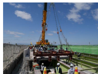
【古い床版撤去状況】
