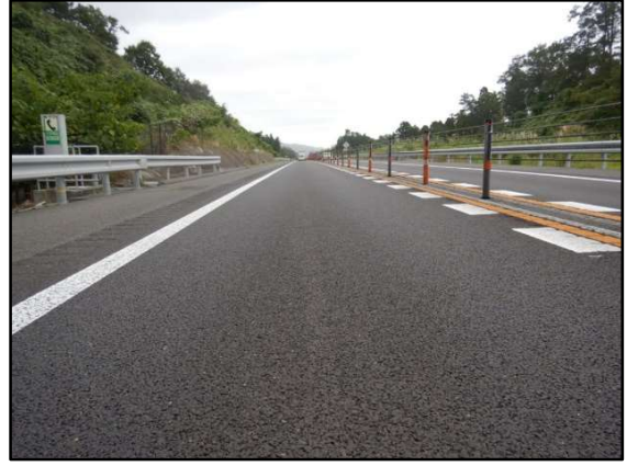
舗装補修後イメージ
