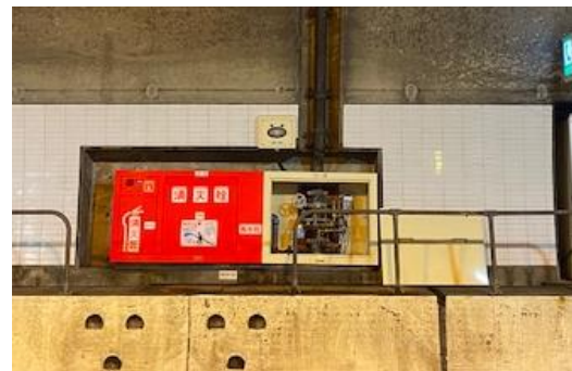
非常用設備更新
