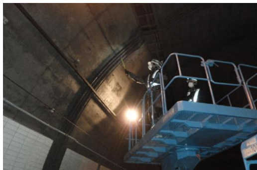
トンネル内設備の点検状況
