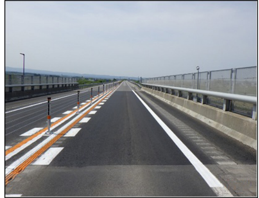
舗装補修後イメージ
