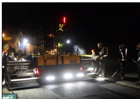
舗装補修工事 作業状況写真
