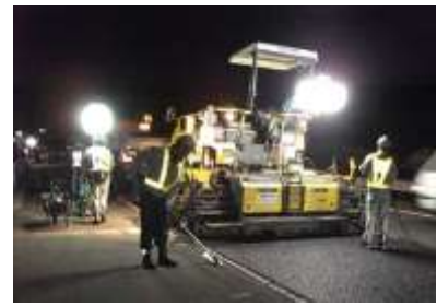
舗装補修工事 作業状況
