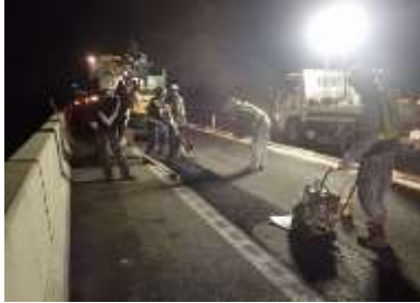
舗装補修工事 作業状況
