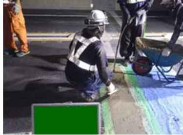
伸縮装置補修工事 作業状況
