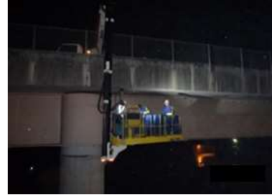
道路構造物点検 作業状況
