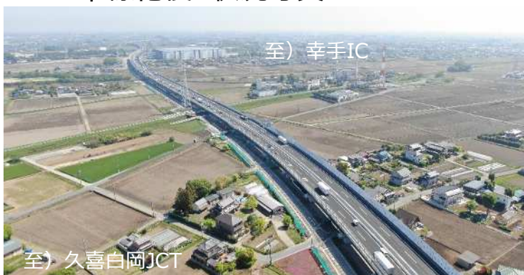
写真③ 久喜白岡JCT～幸手IC 状況
