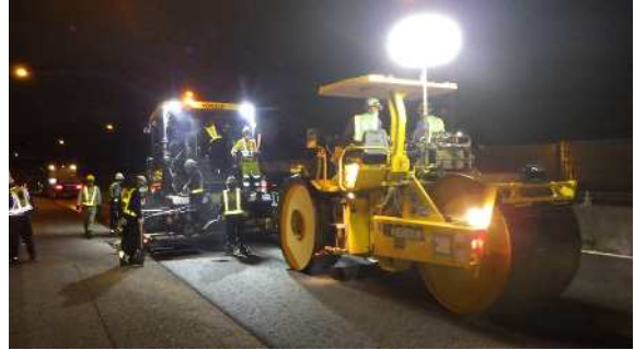
舗装補修工事 作業状況
