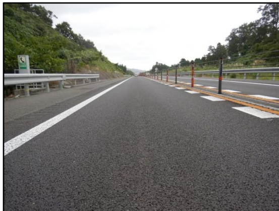
舗装補修後イメージ
