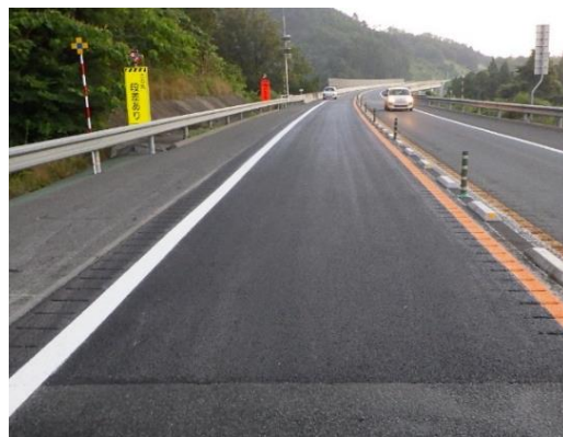
舗装補修後(イメージ)
