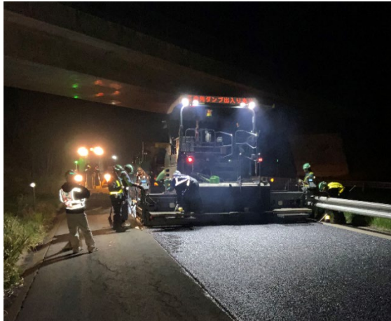
路面補修工事例
