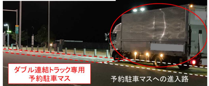
予約駐車マス手前への非予約車両の駐車状況と カラー舗装による対策(E1A 新東名 静岡 SA(下り))
