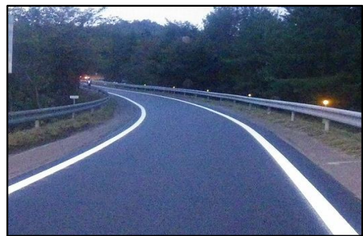
補修完了状況(イメージ)
