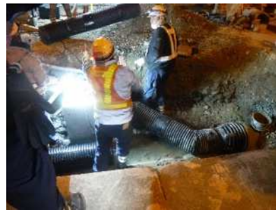
【中央排水切替状況】
