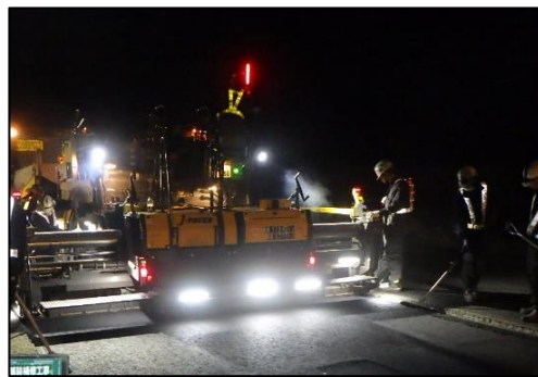
舗装補修工事 作業状況写真
