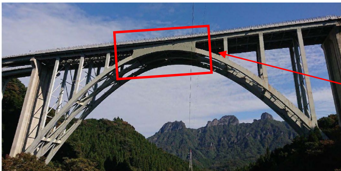
FEM解析モデル (アーチクラウン部の地震時の応力状態を把握するために局所的な3次元FEM解析を実施)
