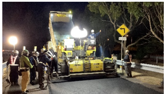
舗装補修工事 作業状況
