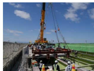
【古い床版撤去状況】
