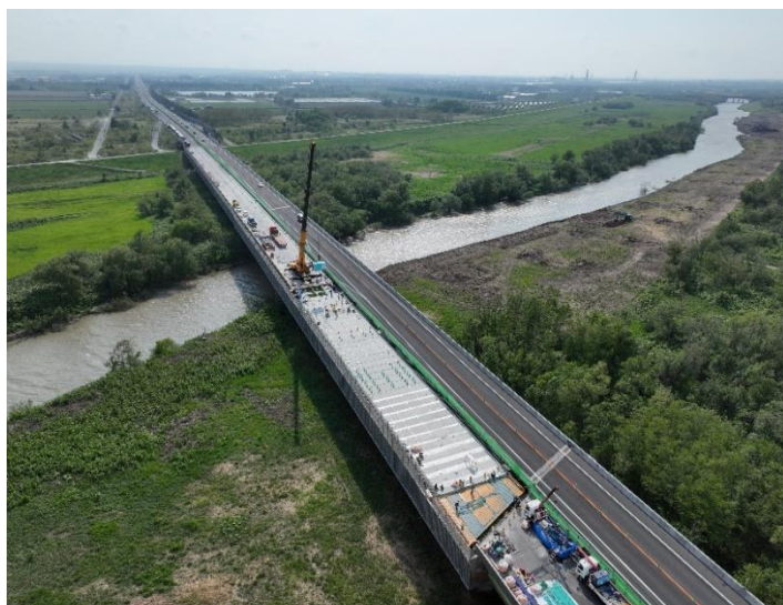
【対面通行規制状況】
