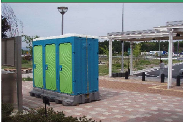
臨時トイレの設置
