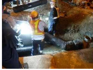
【中央排水切替状況】
