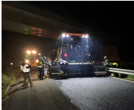
路面補修工事例
