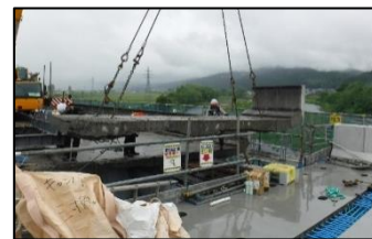
【古い床版撤去状況】
