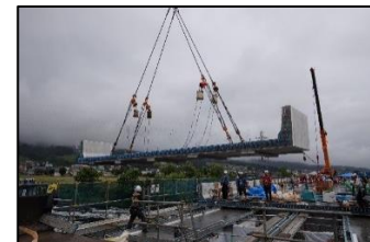
【新しい床版設置状況】
