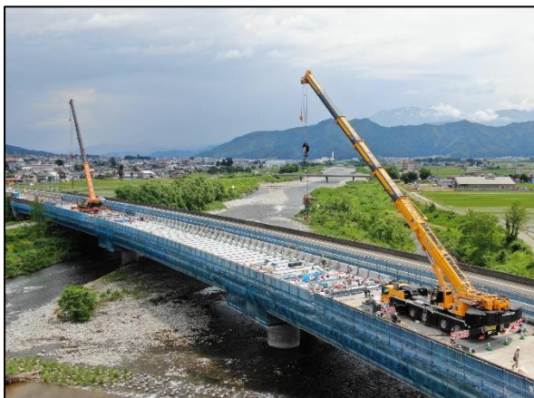
【対面通行規制状況】
