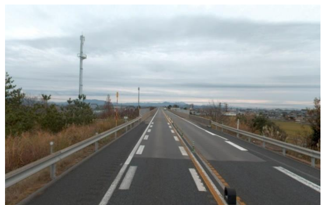
片側1車線道路の場合 ⇒通行止めでの工事を実施
