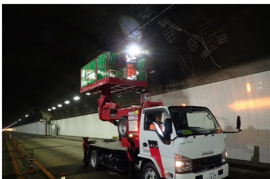
トンネル内設備の点検状況
