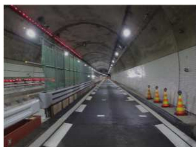
【防護柵設置状況】
