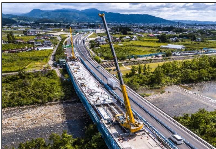
【対面通行規制状況】
