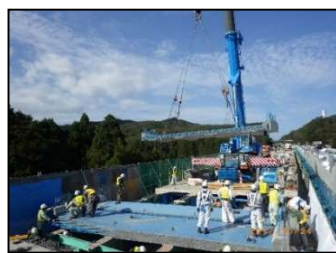
【新しい床版設置状況】
